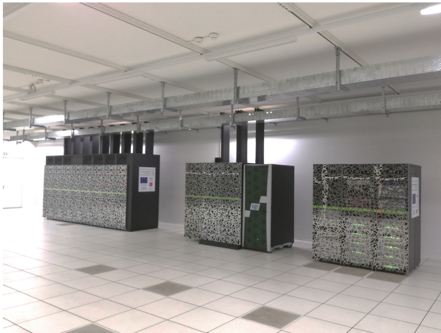
Figure. Le Supercalculateur EOS et le système de stockage ATLAS.
